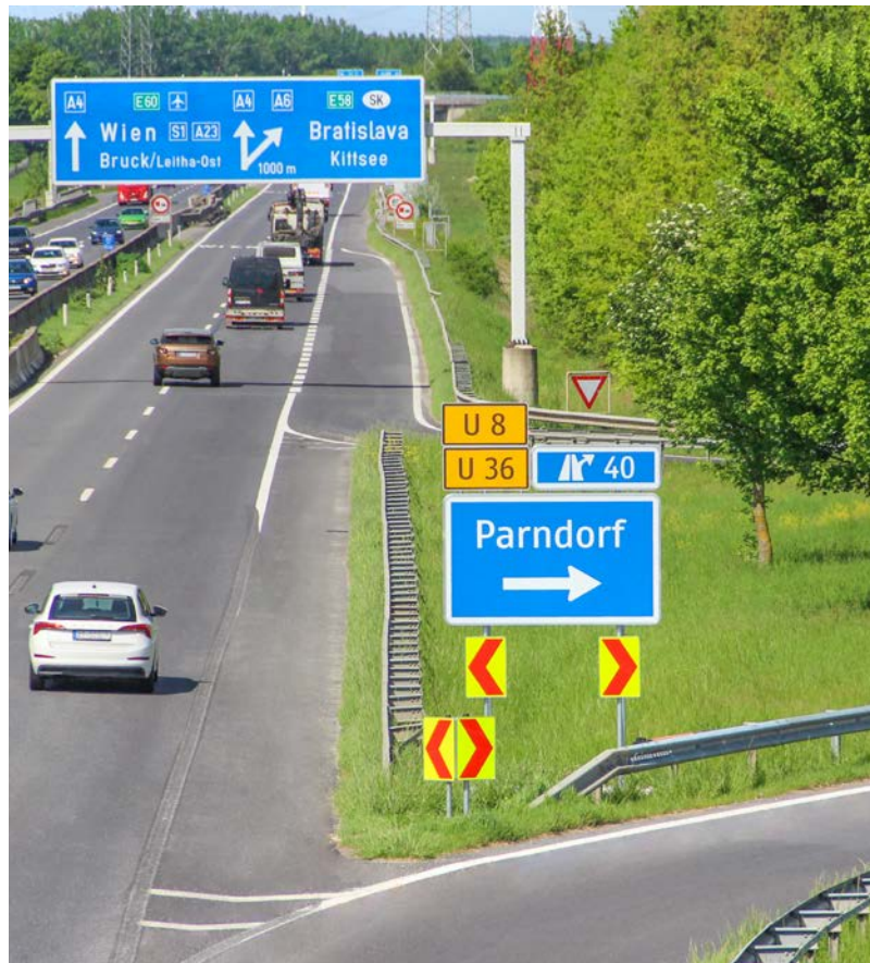
Wieder gut lesbar – der Ausfahrtswegweiser nach Parndorf wurde erneuert.
