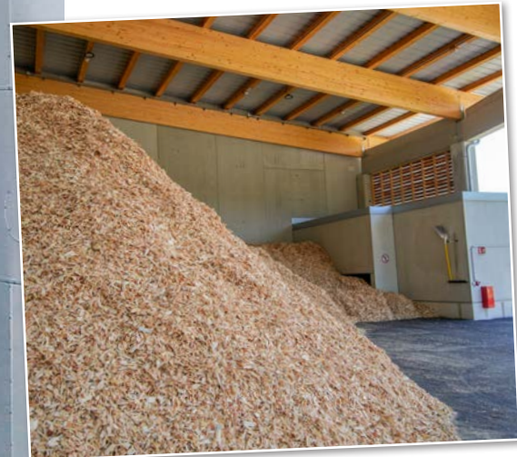
Für die Energiegewinnung wird regionales Hackgut verwendet.
