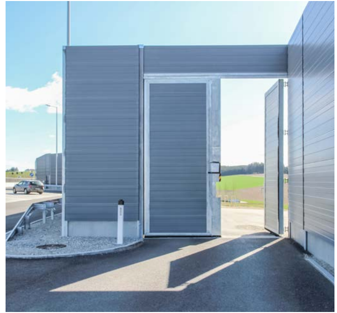
Das Lärmschutz-Drehtor dient der Zufahrt von Einsatzfahrzeugen.
