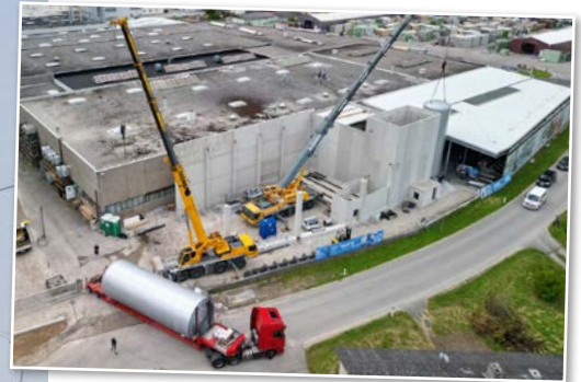
Das Einheben der Pufferspeicher mit je 105.000 Liter Fassungsvermögen erfolgte im Sommer 2024.
