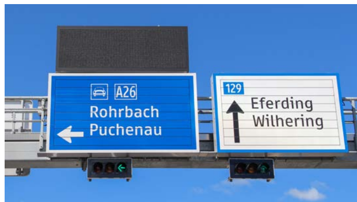
Im Ereignisfall können Prismen-Wechselverkehrszeichen Symbole oder Texte für Straßensperren bzw. alternative Routenführungen anzeigen.
