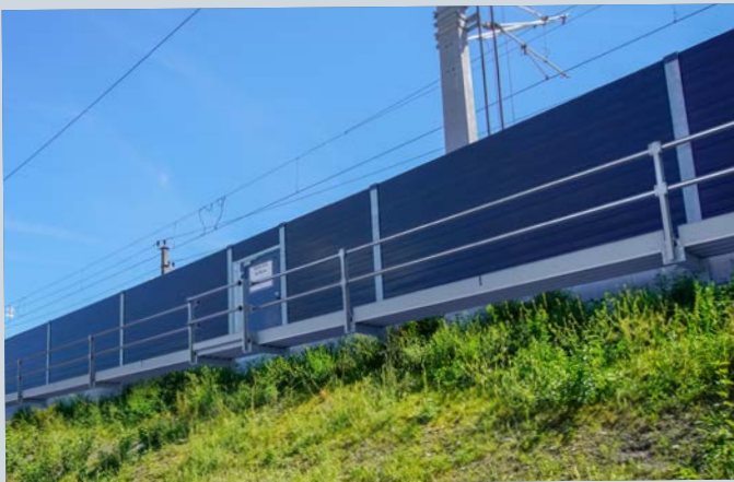
Der FONOCON Inspektionssteg erleichtert den Zugang zu schwer erreichbaren Stellen im Bahnbereich!
