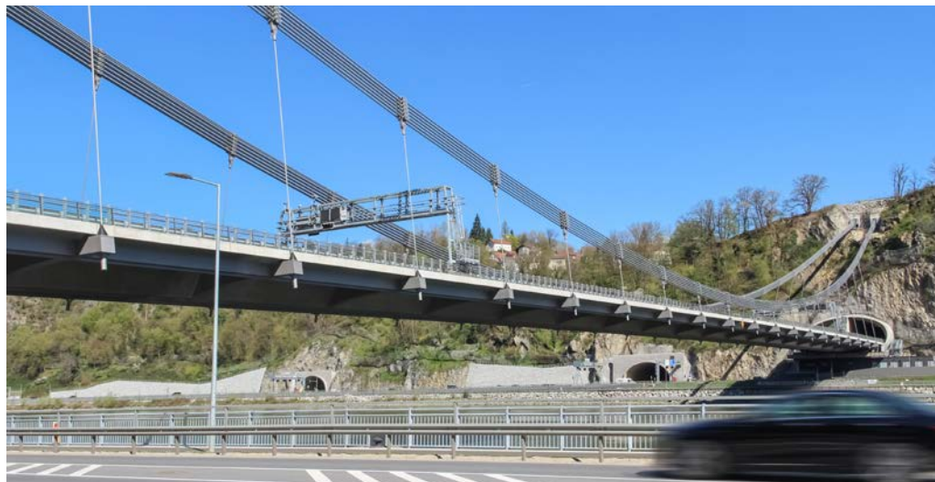
Insgesamt 300 Meter lang und 22,5 Meter breit ist die neue Donautalbrücke.
