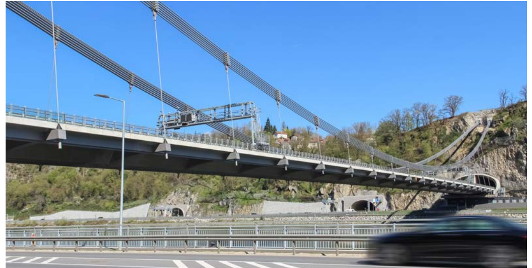
Insgesamt 300 Meter lang und 22,5 Meter breit ist die neue Donautalbrücke.
